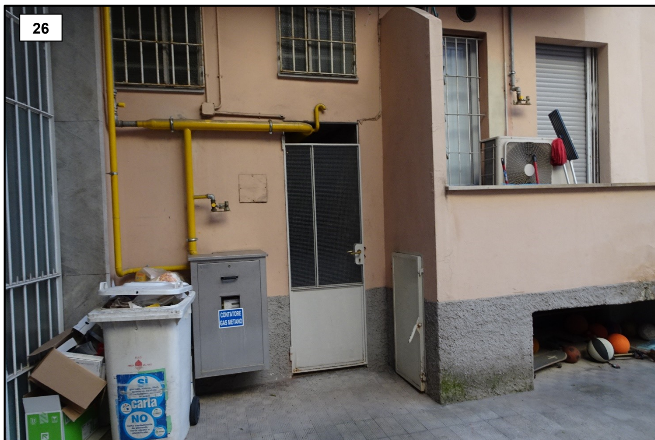
ACCESSO CANTINE (visto da porta)
