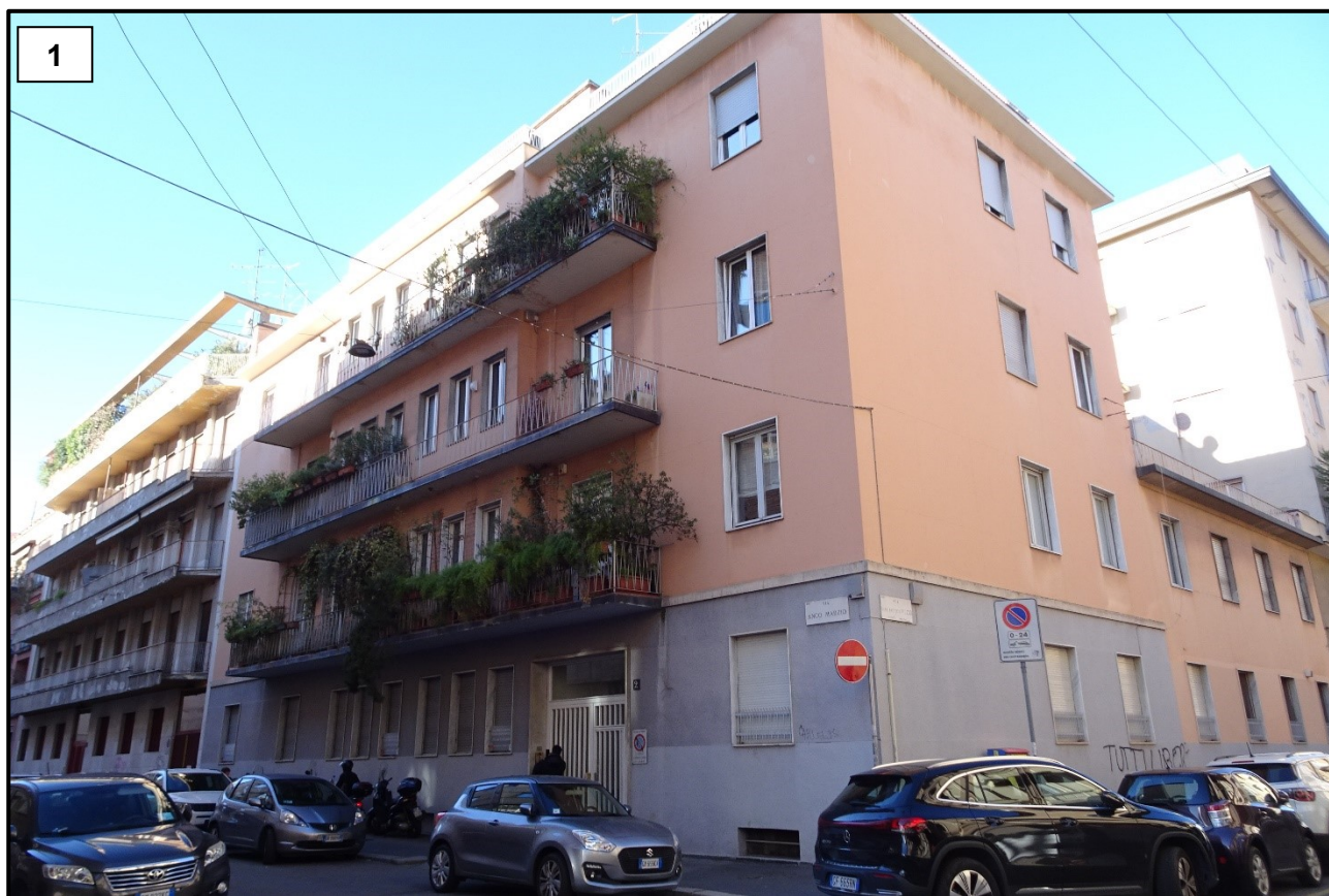
VISTA GENERALE ESTERNA D'ANGOLO DA VIA ANCO MARZIO
