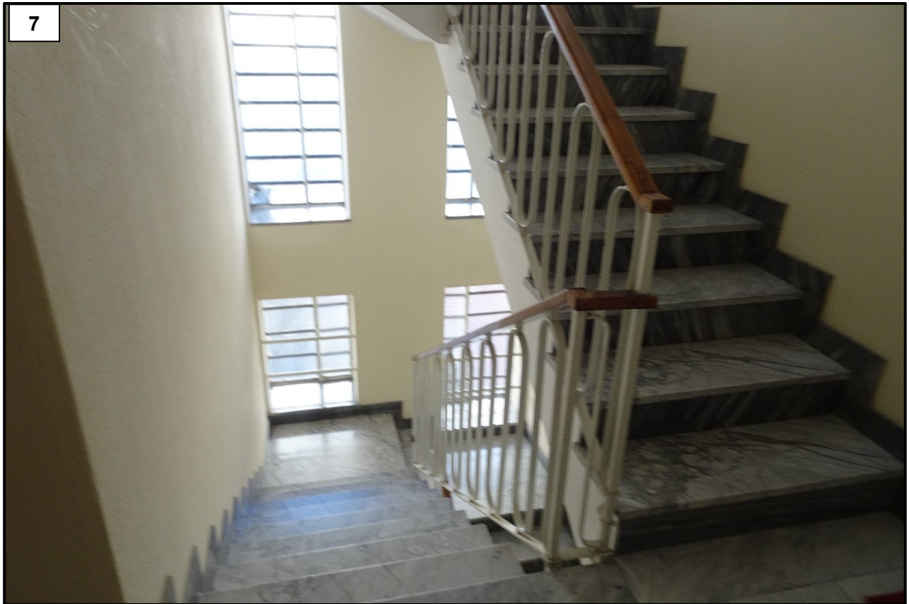
PIANEROTTOLO SCALA (visto da rampa)
